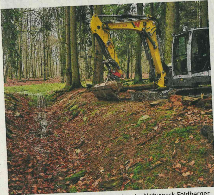
Mit dem Minibagger wird diesem Graben im Naturpark Feldberger Seenlandschaft zu Leibe gerückt. Die Gräben werden mit sogenannten Erdplomben verschlossen, damit das Wasser nicht mehr abfließen kann.
